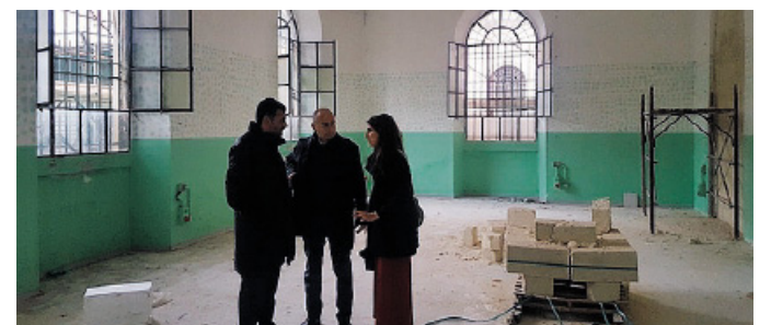
IL CANTIERE L'ala in ristrutturazione
